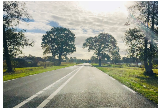
Bermbeveiliging en -geleiding ontbreekt en bomen staan op korte afstand van de rijbaan
